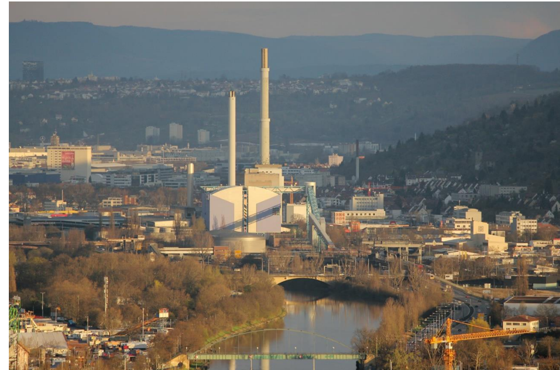
Kohle-Kraftwerk Stuttgart, Leistung 195 MW elektrisch 273 MW Fernwärme
